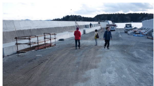
写真4 魚竜館の跡・解体が終わっていた
